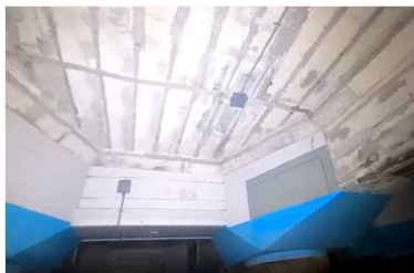
写真1 線状陽極設置写真
