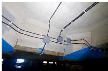
写真2 面状陽極設置写真
