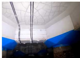
補修工事（電防設置）状況写真
