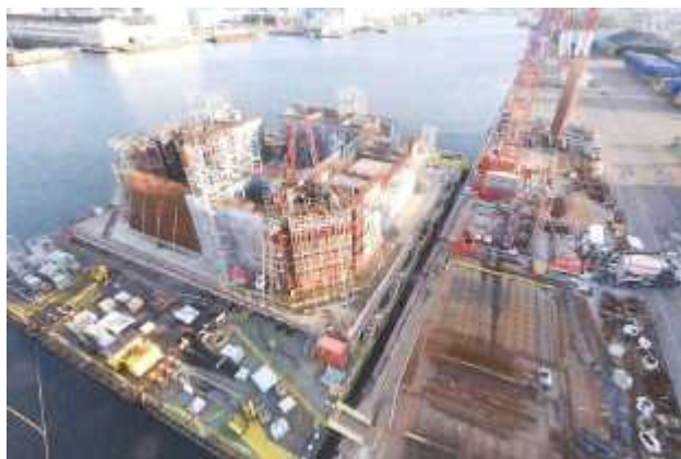
工事状況：壁体部
